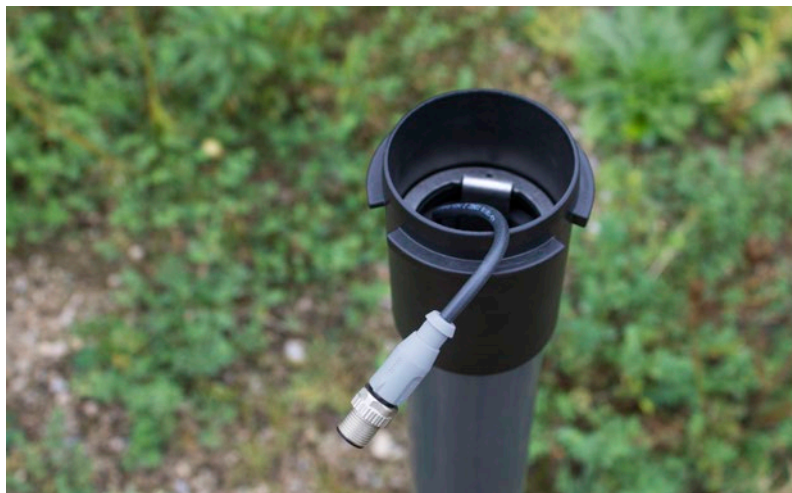
Figura 6-6 Baje el conjunto dentro del pozo
