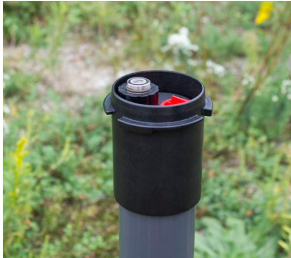
Retire la instalación del levellogger existente
