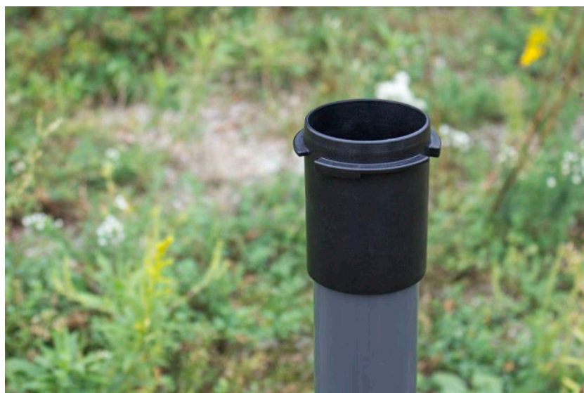
Figura 6-3 Instale la base del tapa pozo
