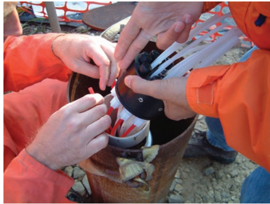
Figura 9-3 Tubería de bomba que se conecta a un cabezal de pozo
