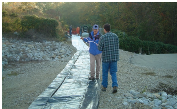
Figura 6-2 Tubería que se lleva hasta el punto de referencia
