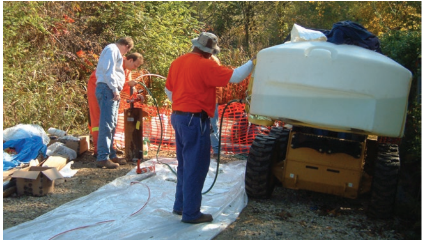
Figura 8-1 Agregado de agua al sistema
