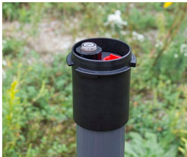
Retrait du système Levellogger existant
